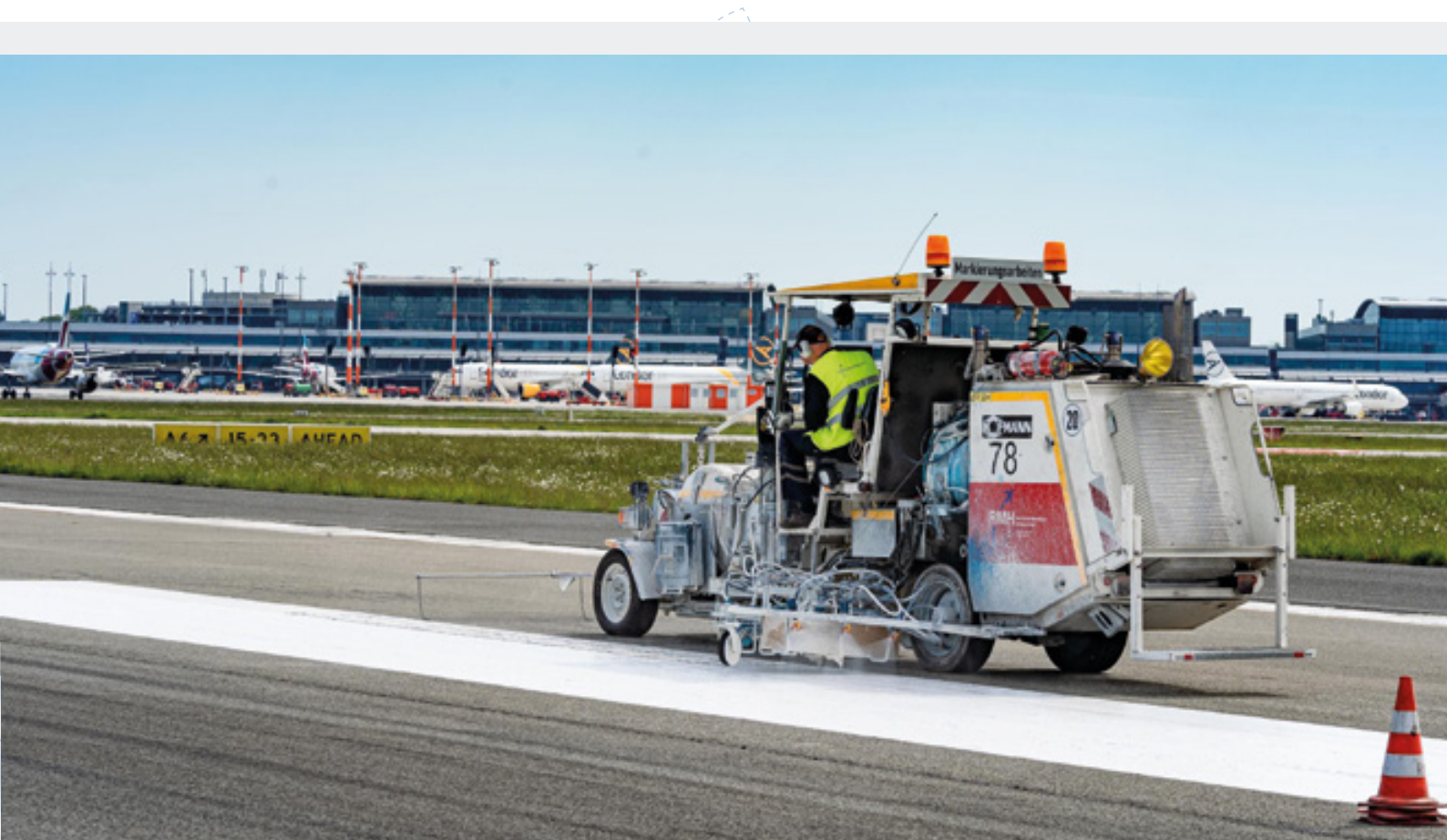
Pistensanierung im vollen Gang. Foto: Flughafen Hamburg
